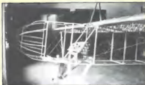
На этих снимках – постройка планера АВФ-10 в школе. На нижнем правом снимке - планер АВФ-10 бис
